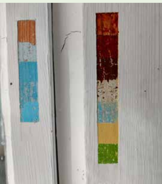
ALKUPERÄISESTÄ ULKOSEINÄSTÄ LÖYTYI RAAPUTTAMALLA MONIA VÄRIKERROKSIA.
