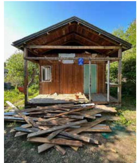
Kuistin purkua. Lopulta vain katto jäi jäljelle oven ja ikkunoiden lisäksi.
