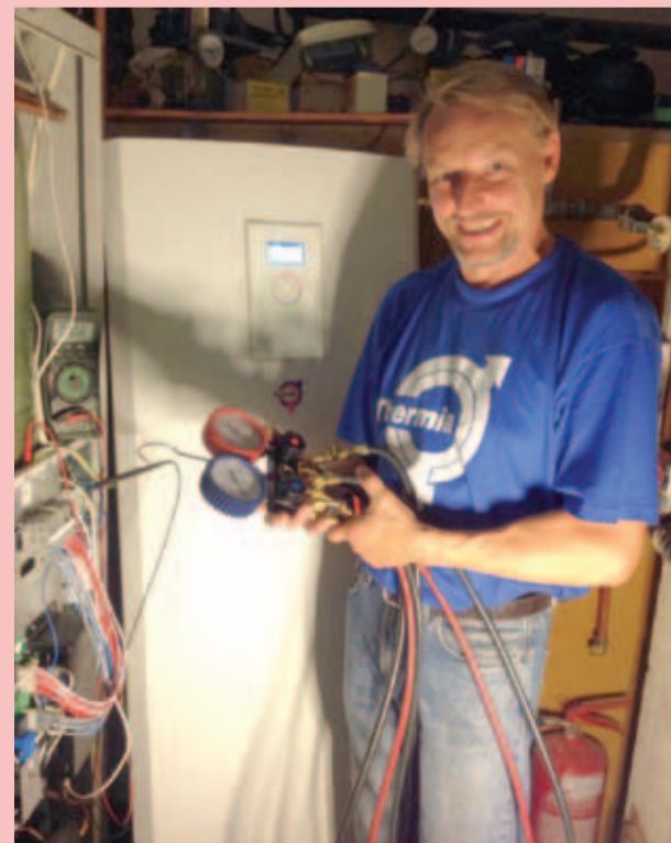
Lasse Widen tekee uutta työtä lämpöpumppujen parissa.
