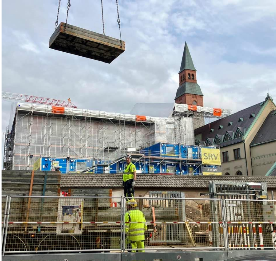
Kuva 2 – Uudisrakennuksen työmaa, ja sen taustalla Kansallismuseon päärakennus. Kuvassa hyödynnetään työmaan raskaan kapasiteetin nosturia. Kuvaaaja: Matti Heimonen
