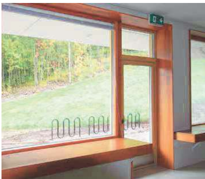
Alavus Ikkunat Oy toimitti noin 70 kpl avattavia ja kiinteitä puualumiini-ikkunoita sekä paloikkunoita Kirkkojärven päiväkotiin. Suurimmat lasit on karkaisu- ja laminoituja turvallisuuden parantamiseksi.
