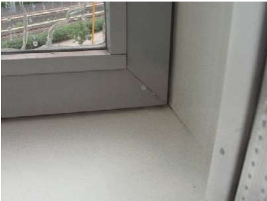
Kuva 4. Vesivuoto alumiinisen ulkopuitteen jiiriliitoksessa.
