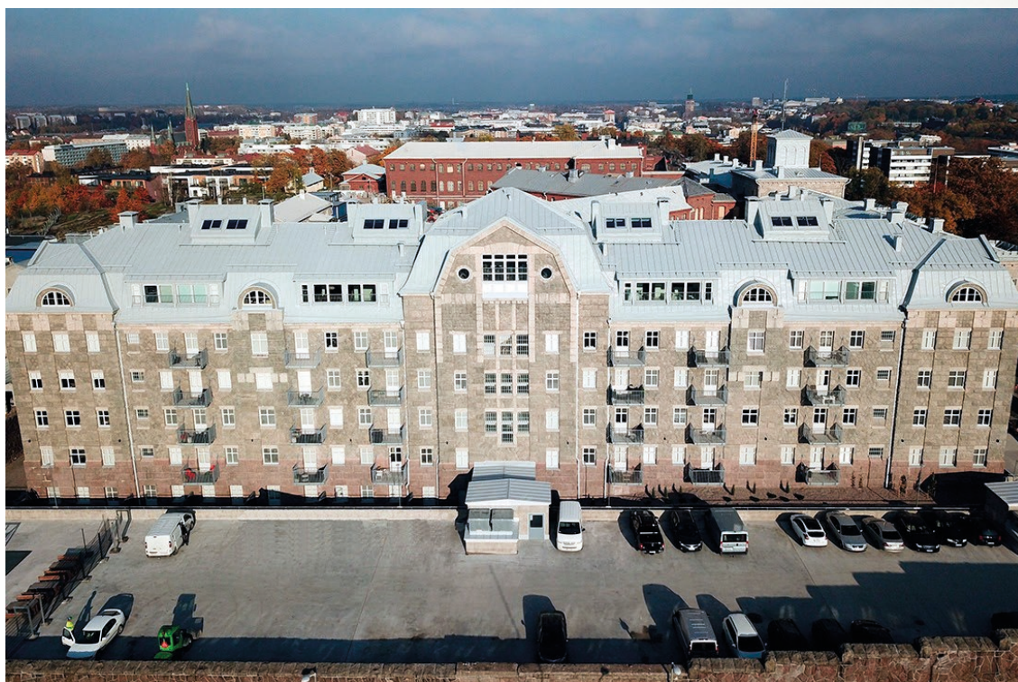
Kakolan ikkunoiden uusiminen oli Lasivuorimaaalle valtava urakka, kun ikonisesta vankilasta muokattiin asuntoja ja muita toimitiloja.
