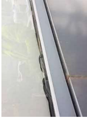
Kuva 3. Lämpöliikkeen hallintaan suunniteltu kuumauden vaikutuksesta, tuuletusajuväly taipuu ja maali lohkeaa.
