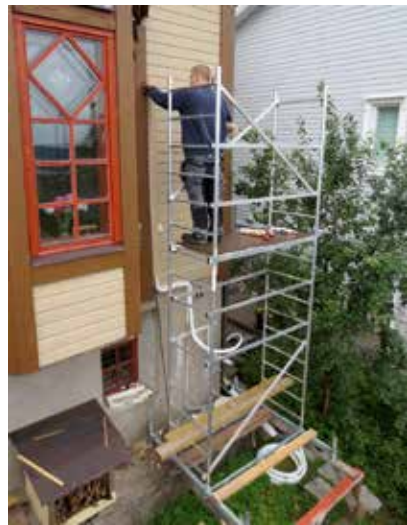
Uuden laitteen asennus käytössä. Suurin työ oli uuden putkituksen tekemisessä.
