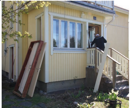
80-luvun ulko-ovet saivat kyytiä, tilalle lämpöpihit ja murtosuojatut versiot
