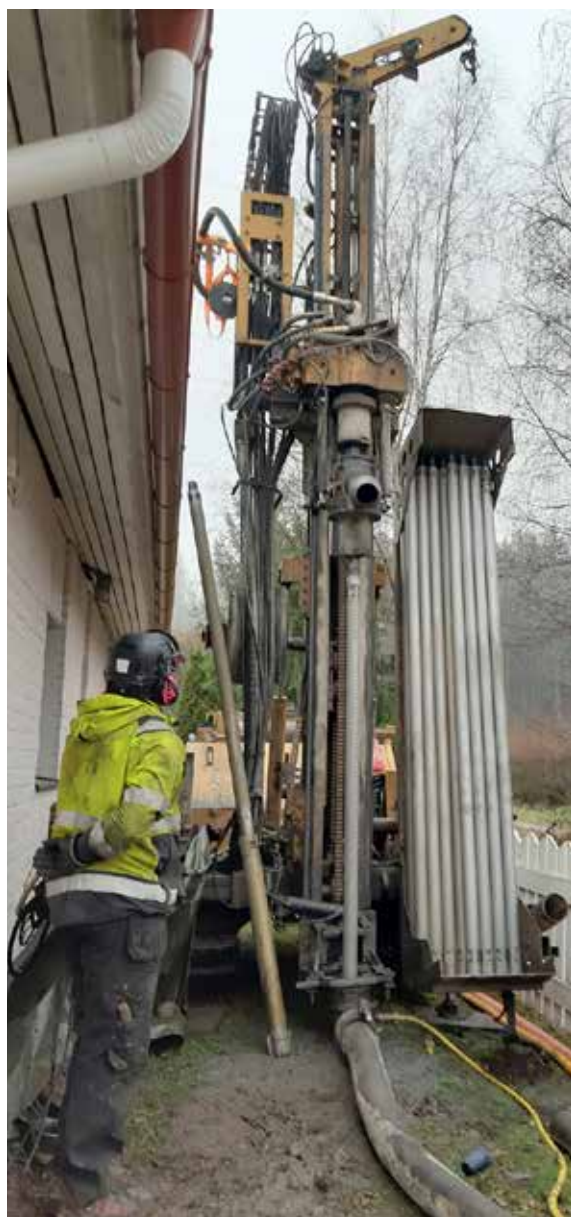
Kone jyskytti Ojakankaan pihalla ja syvälle mementiin kallioon lämpöä kohti.
