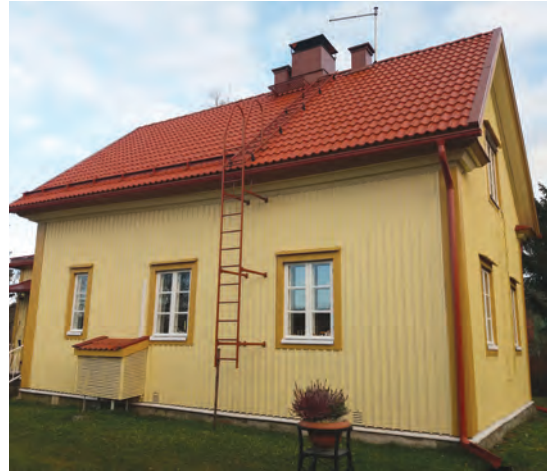
Vesivekin sopimukseen kuuluivat katon lisäksi myös mm. vesikourut ja lumiesteet sekä tikkaat
