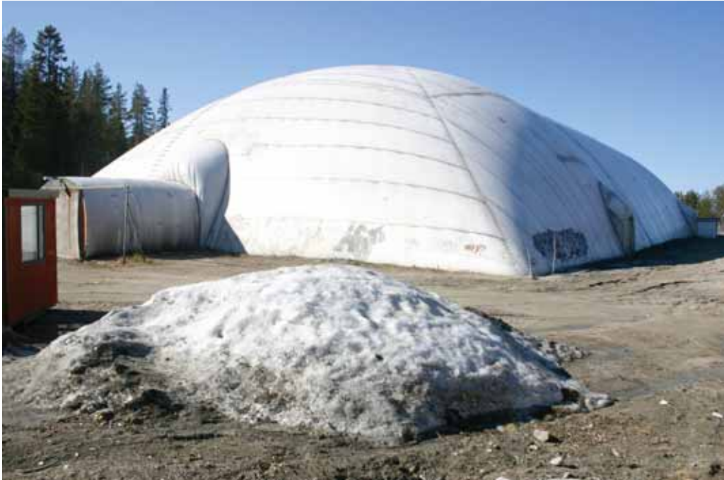
Pyrimön hankkimaa toista kuplahallia käytettiin jääliikuntaan ja -urheiluun yksitoista talvea 2000–2011. Kuva purkamista odottavasta hallista 12.5.2011. (Kuva: Reino Hämeenniemi)
