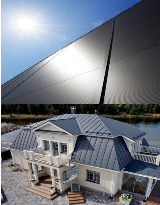
Rakentaminen - katot, julkisivut
