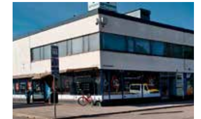
KOTKA, myydään Liikehuoneisto 207,0 m 2 Vesivallinaukio 3 Lh 8-9
