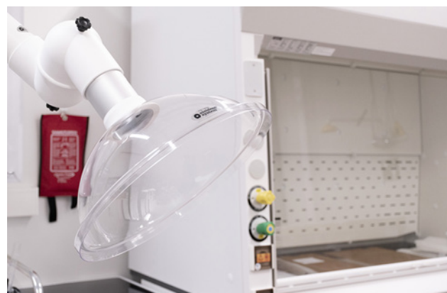
Kohdepoisto eli imukärsä. Taustalla vetokaappi, jossa tällä hetkellä luettelointia odottavaa paperimateriaalia.
