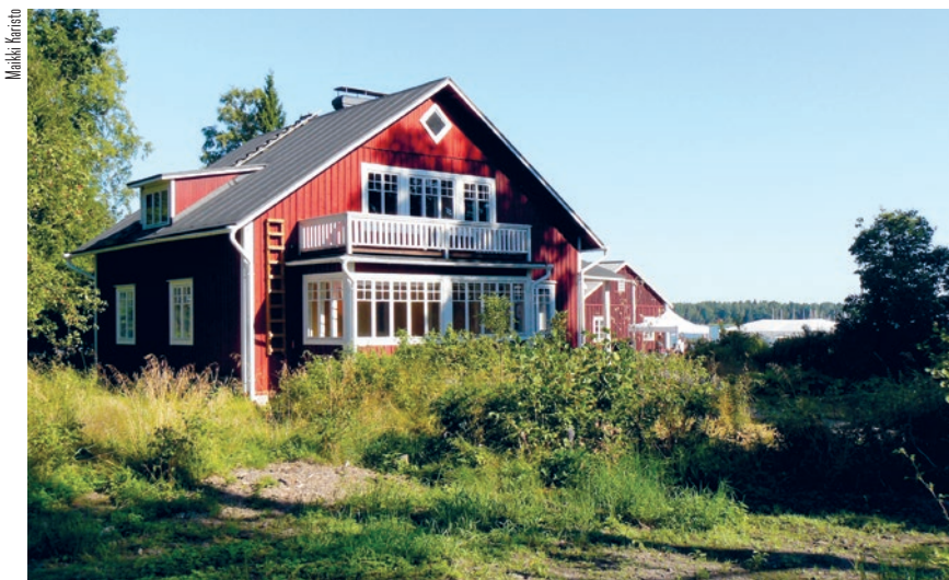
Kuva 1: Gurli Nyholmin talo. Näkyvissä lasiveranta ja yläkerran ikkunat.
