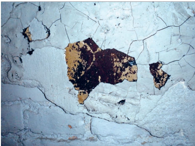
PAH-yhdisteitä sisältäviä sivelyjä seinäpinnoilla.
