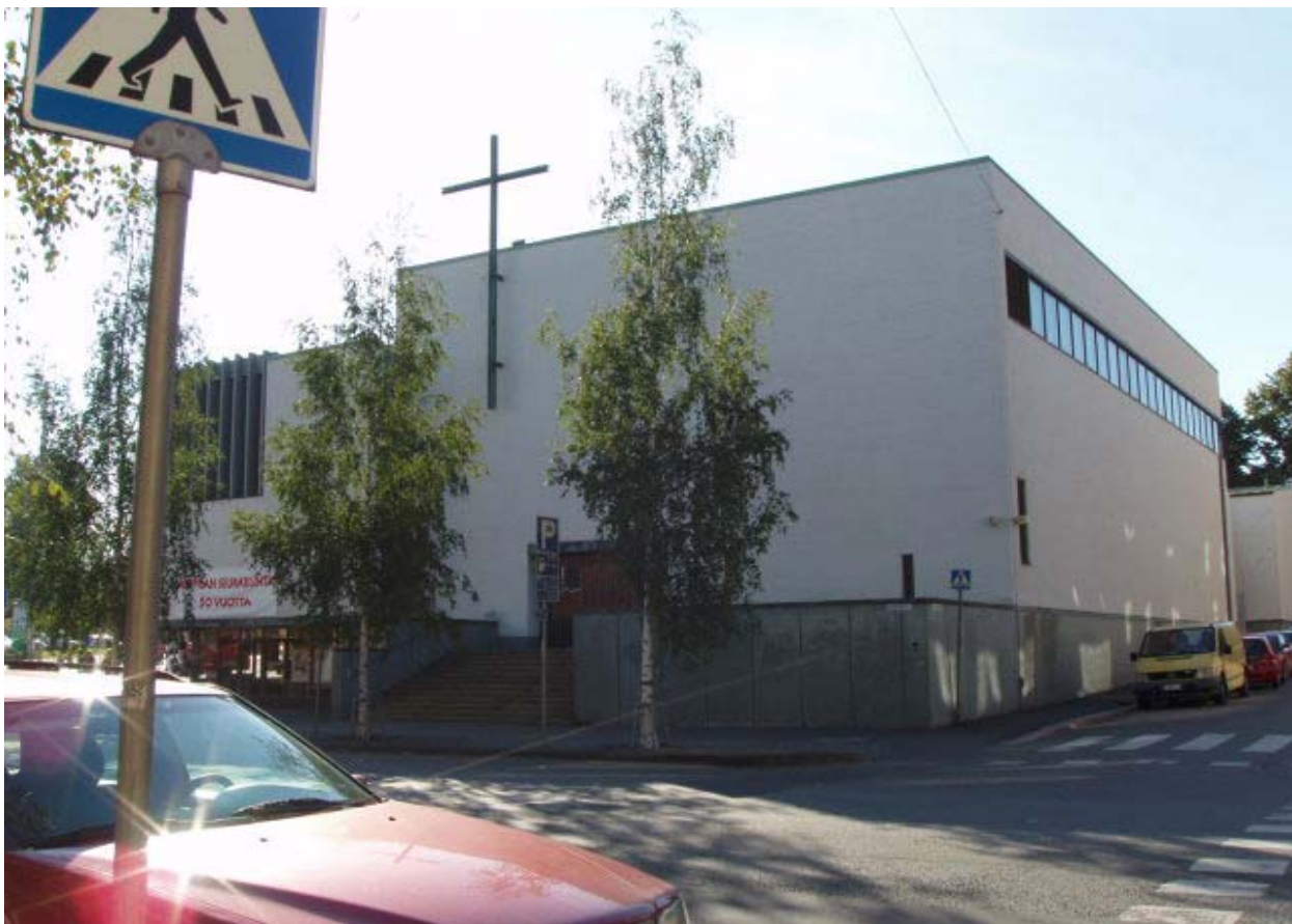
Kuva 1. Tämän kevään opinnäytteiden joukossa valmistuu kirkkorakennusten ennaltaehkäisevän konservoinnin ja irtaimistoturvallisuuden kysymyksiä tarkasteleva tutkimus. Keväällä 51 vuotta täyttävä Alppilan kirkko on yksi ylemmän ammattikorkeakoulututkinnon opinnäytetyön kartoitetuista kirkkorakennuskohteista. Kuva: Heidi Wirilander
