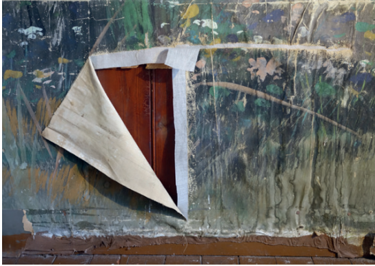
Repeämät korjattiin tukikankaiden avulla. Kuva: Kuustie&Sorri oy 2014.
