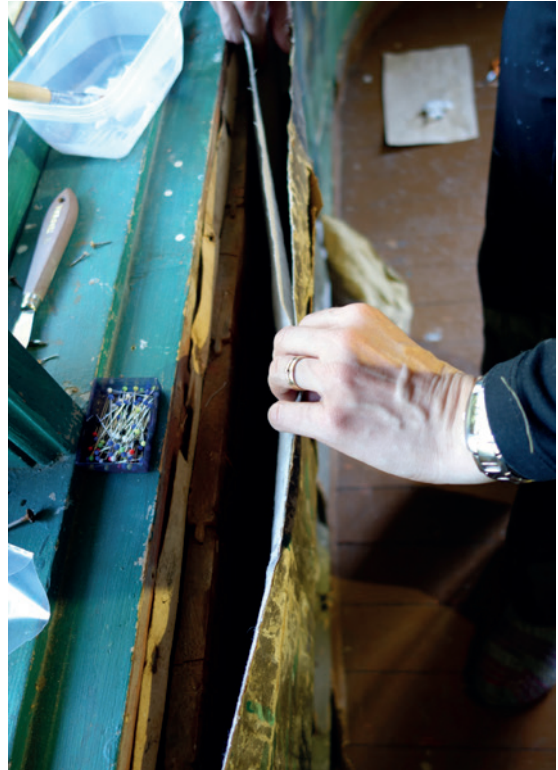
Vahvistuskangasta asetellaan kankaan taakse. Kangas liimattiin paikoilleen ja naulattiin karmiin kiinni. Kuva: Kuustie&Sorri oy 2014.
