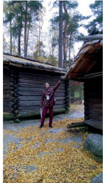
Konservaattori Erkka Pajula esittelee rakennuksen uusittua tuohimalkakattoa Niemelän torpan pihapiirissä. Kuva: Stina Björklund.
