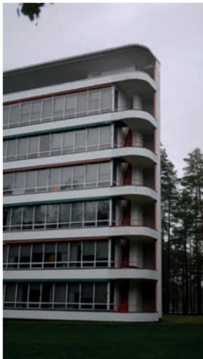
Hätäpoistumistie on puhdasta Alvar Aaltoa.
