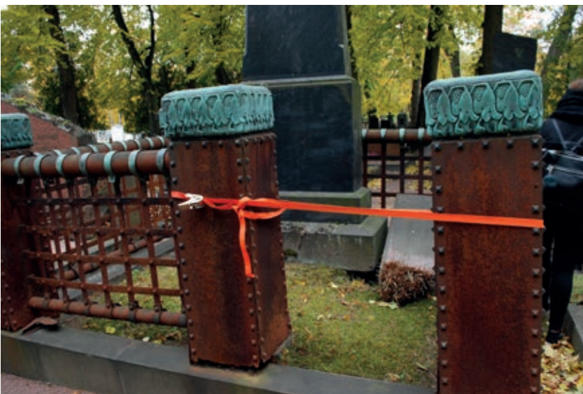
Metropolian konservoinnin opiskelijat ovat tehneet töitä erikoisen hautarakennelman kanssa. Nyt sen metalliosia tuetaan väliaikaisesti liinoin.
