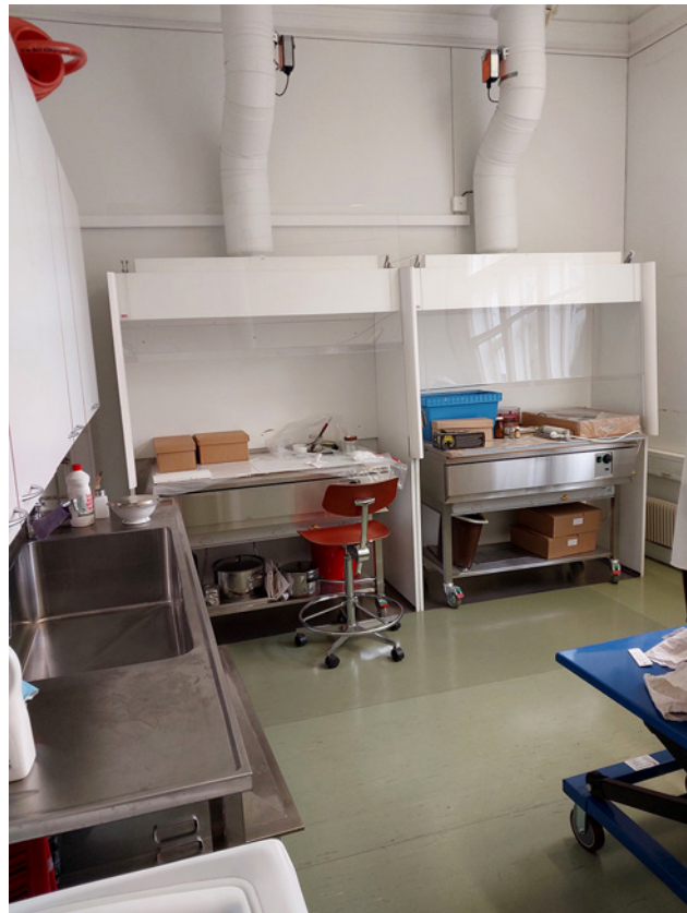
Konservointitilojen kiinteä sisustus on pääasiassa 1970- ja 1980-luvulta lukuun ottamatta 2000-luvulla hankittuja vetokaappeja. Kuvassa lämmitettävillä allaspöydillä varustetut, näiden lisäksi yksi kiinteäpöytäinen vetokaappi ja kemikaalikaappi.
