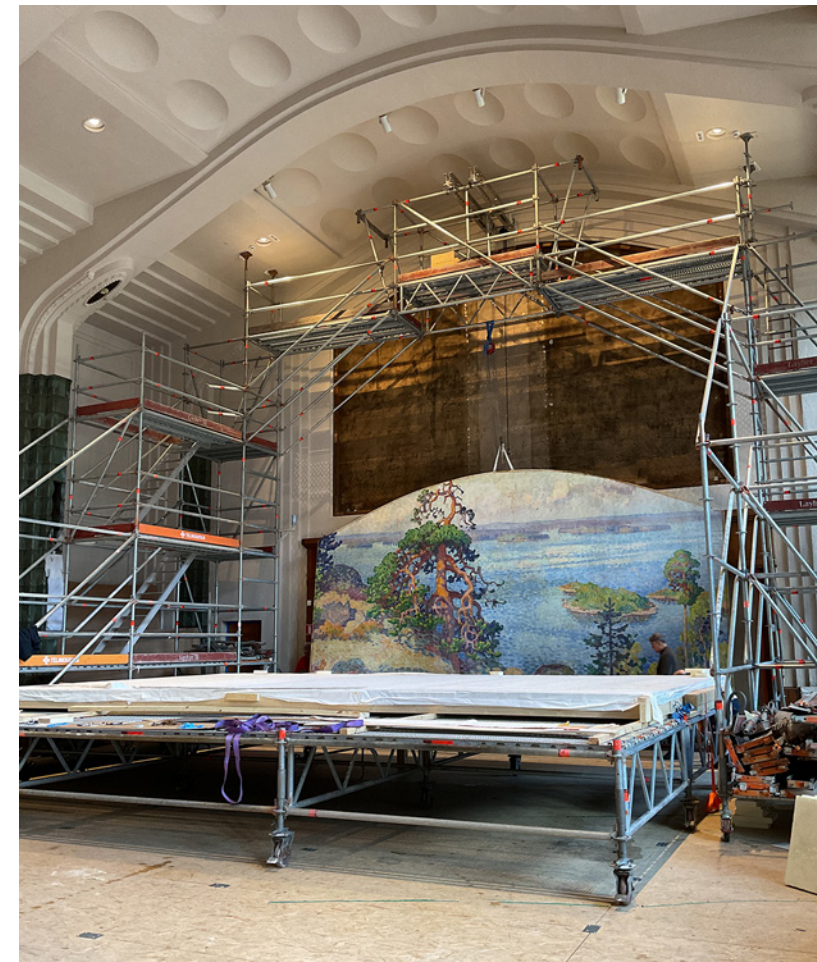
Teos pingotuksen jälkeen pystyssä.
