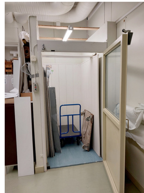
Vuonna 1985 asennettu tavaralavanostin on pieni ja sitä voi ohjata vain tästä kerroksesta, eli kun kuljetetaan tavaraa konservointitiloihin, pitää kiivetä portaat ylös ja painaa nappia koko matkan.
