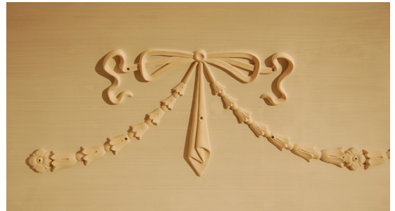
Vaunun A100 salonkiosaston kattoon toteutettiin myöhemmissä vaiheissa sieltä jo poistettu alkuperäisen mallin mukainen koho-ornamenttikoristelu.
