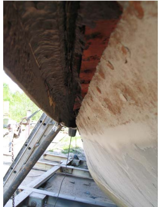
Kyljen ruostevaurioita takahytin kohdalla kylkilistan alta
