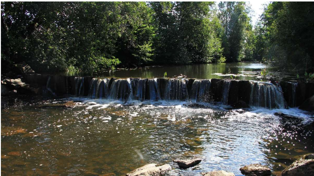
Kuva 6-5. Noin 7 km Lapinjoen suulta ylävirtaanpäin sijoittuva teräsponttipato katkaisee vaellusyhteyden Lapinjoen alaosan koskille.
