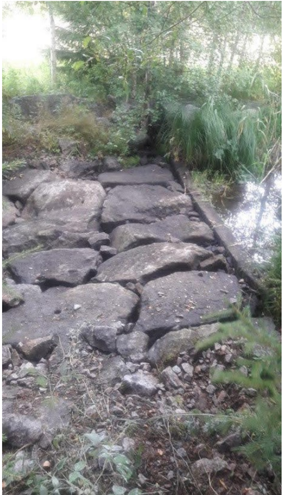
Kuva 1: Turajärven säännöstelypato kesävedenpinnan tasossa.
