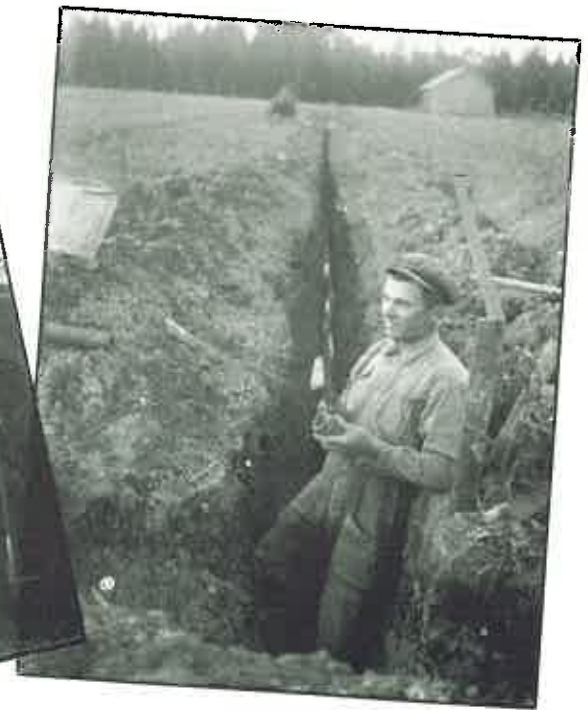
6) Kauralan tilan peltoja salaojitettiin ensimmäisinä Somerolla. Aluksi ojat kaivettiin lapiolla, ojassa isäntä Yrjö Kaurala laskemassa putkia ojanpohjalle.
