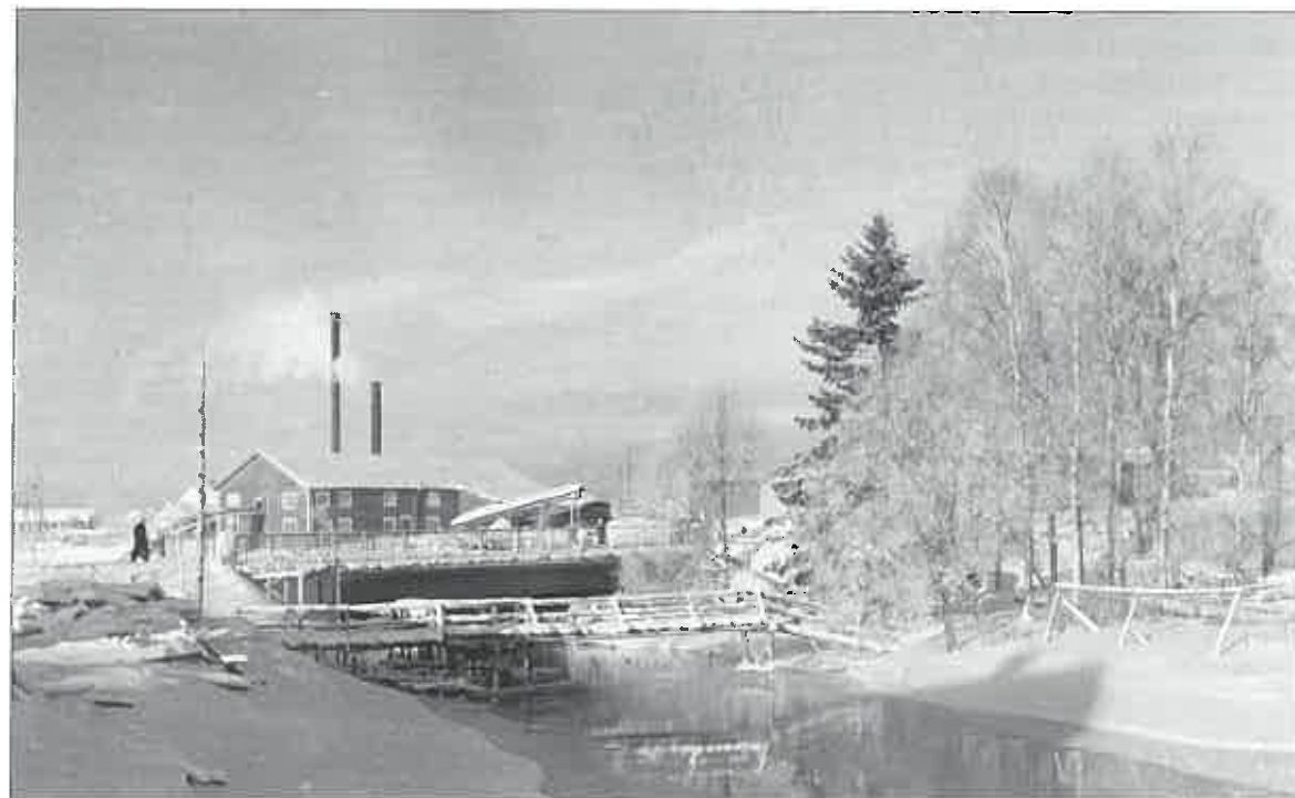
Someron saha. Silta Paimionjoen yli valmistui vuonna 1957.
