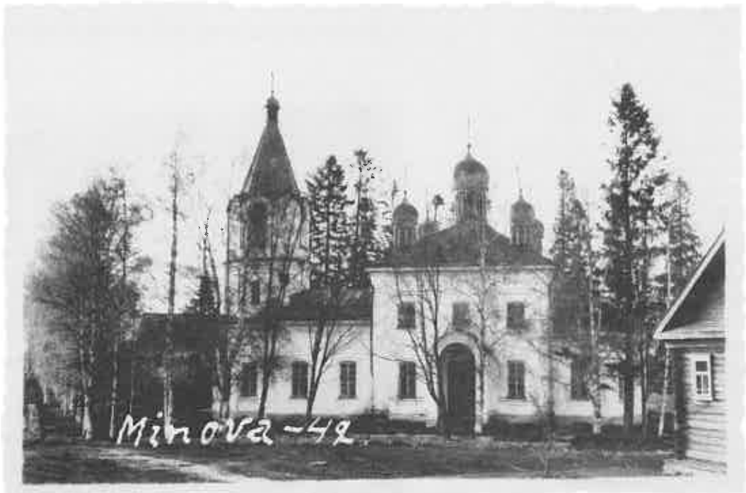
Minovan kirkon kiviaidan viereen juostiin monta kertaa suojaan pommituksen sattuessa.
