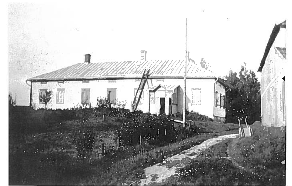
Luukkalan päärakennus alkuperäisessä asussaan. Oikealla paperitehtaan lumppukoppi, joka hajotettiin 1947. Kuva Eeva Kuisman.
