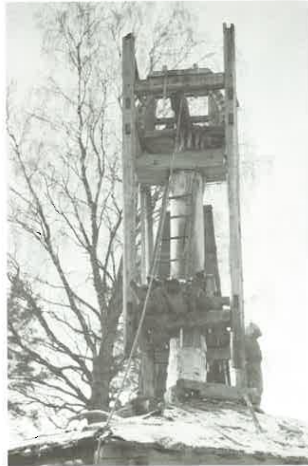
Niittymäen tuulimyllyn purkamisvaihetta (vrt. Sireliuksen kaavakuvaan). Siipeä irrottamassa urakoitsija Elis Eloranta. Valok. Aulis Juvonen 18. 11. 1963.
