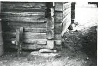
Museon riihen nostoremontti 7.—15. 9. Remonttimiehet: Lauri Koskinen, Veli Lukumies ja Mauri Roto. Valokuvat Voitto Ollonqvist.
