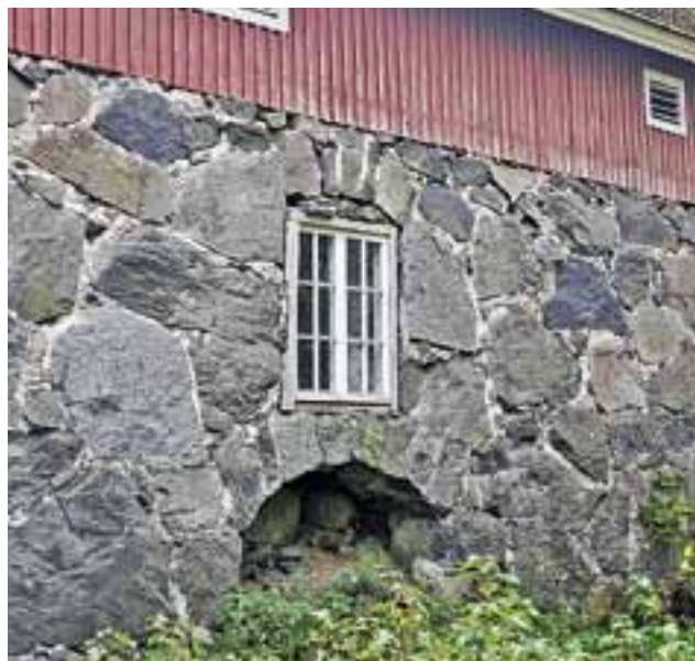
Yksityiskohta kivilavetan holvauksesta. – Kuva Sauli Kaipainen.
