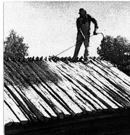
Hannu Yli-Rekola (vas.) ja Kauko Tuominen ruiskuttavat tervaa museon uusittuihin malkakattoihin 14. 7. 82. Valok. Tapio Horila.
