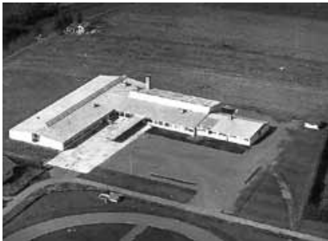
Uusi uljas koulumme. Kuvan oikeassa laidassa oleva pieni rakennus toimi ulkokuhuussina, jolloin sitä lähinnä oleva siipirakennus oli vasta saatu käyttöön.
