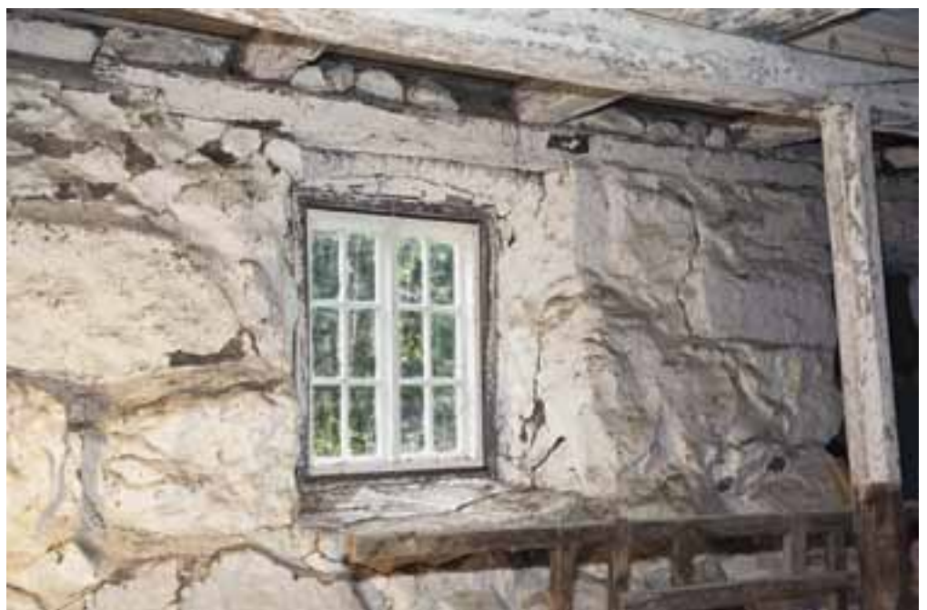
Sisäkuva kivinavetan kalkitusta sisäseinästä. – Kuva Sauli Kaipainen.
