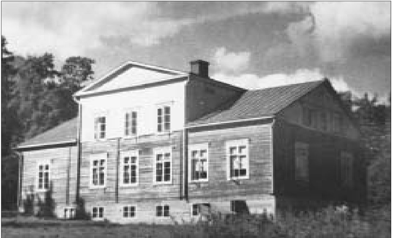
Vanhalan päärakennus 1940-luvulla. Hirsiseinät rapattiin 1950-luvulla. Kuva kirjoittajan.
