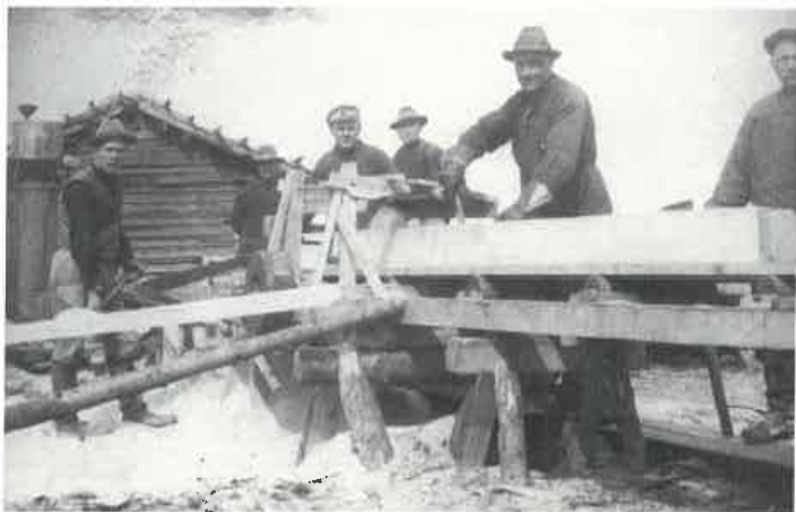
1920-luvun rakentamista vauhditti jo siirrettävä ns. kenttäsiirkeli. Kuvassa seppämestari Juho Jaakkola Koistuhdasta (neljäs oikealta) sirkeleineen ja toisena sahurina Oskari Elomaa (toinen oikealta).
