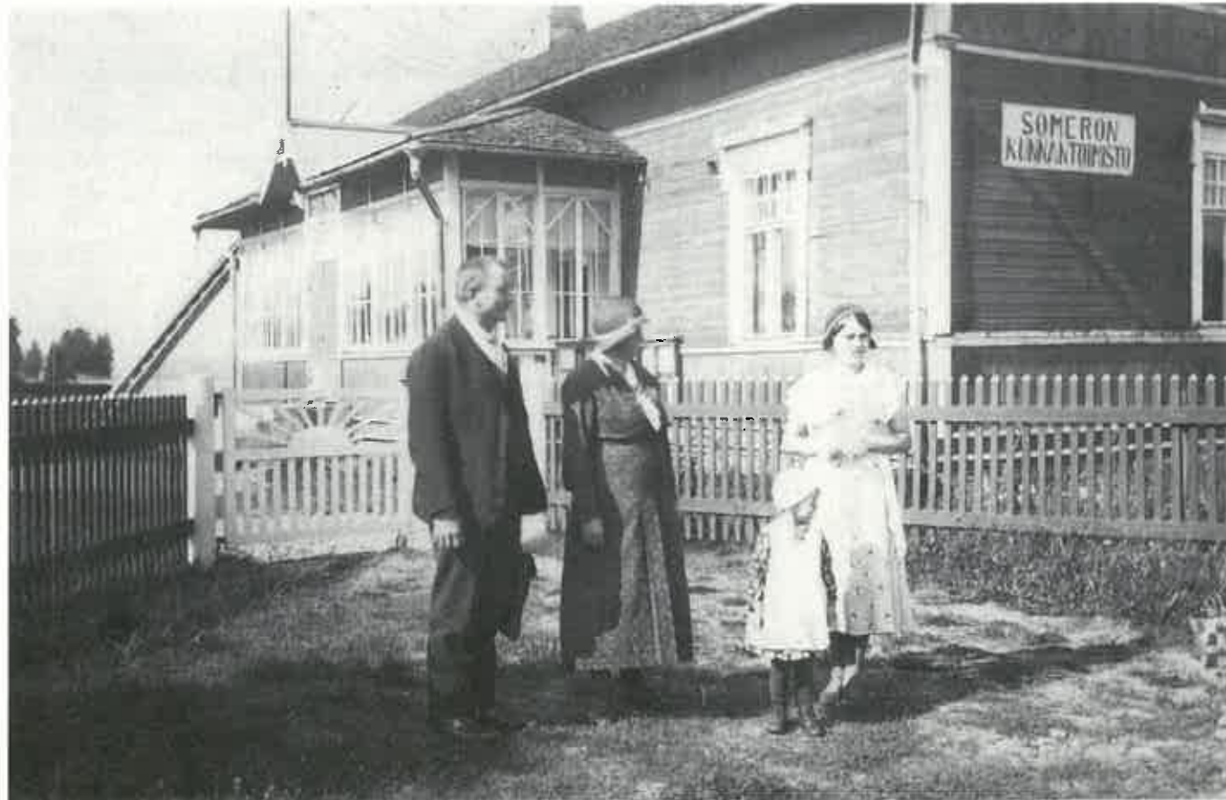
August ja Ida Jutila sekä tyttäret Aino ja Helvi Someron kunnantalon ja sen "aurinkoportin" edessä kesällä 1933. Lasiverannalta sisään mennessä tultiin suoraan kokoussaliin. Siitä oikealle päätyhuoneessa oli kunnantoimisto. Rakennuksen vasemmanpuoleisessa eli länsipäädystä sijaitsi kunnankirjuri Jutilan kaksi huonetta ja keittiön käsittävä asunto. Uusi kunnantalo valmistui 1939 kuvan etualalle, vanhan talon eteläpuolelle.
