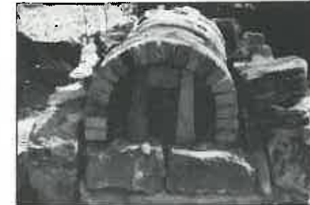
Savupirtin uunin uudelleen rakentaminen oli tarkkaa työtä. Uunin muurasi Lauri Koskinen Voitto Ollonqvistin tarkkojen piirustuksien mukaan. Valokuva: Voitto Ollonqvist
