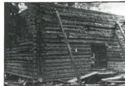
Savupirtin hirsiosa valmiina. Lauri Koskinen, Veli Lukumies ja Mauri Roto ruokatunnilla 15.5.85. Valokuva: Voitto Ollonqvist
