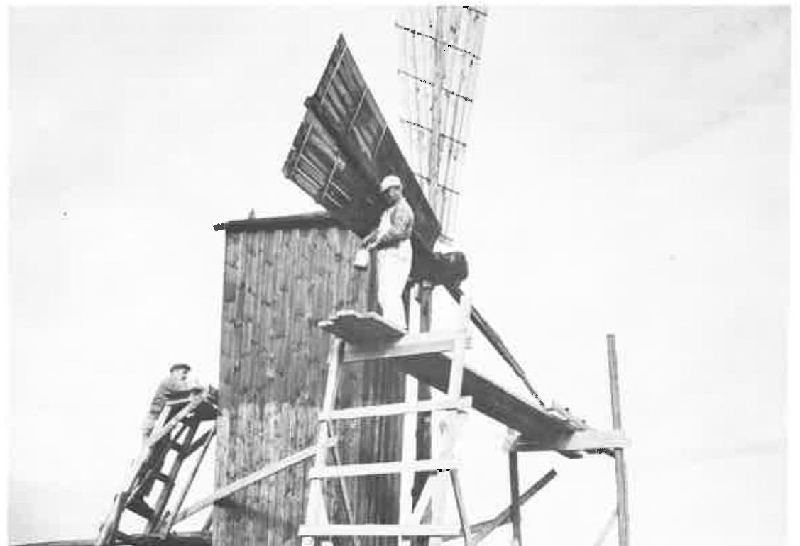
Unto Rämö (oik.) ja Helmo Frankberg korjasivat museon tuulimyllyn siivet ja käsittelivät lajituksen koko lautarakennelman lahonsuoja-aineella. He nostivat myös eräitä museon painuneita piharakennuksia ja uusivat lahonneita multahirsiiä. Valok. Sisko Pesonen 6. 9. 71
