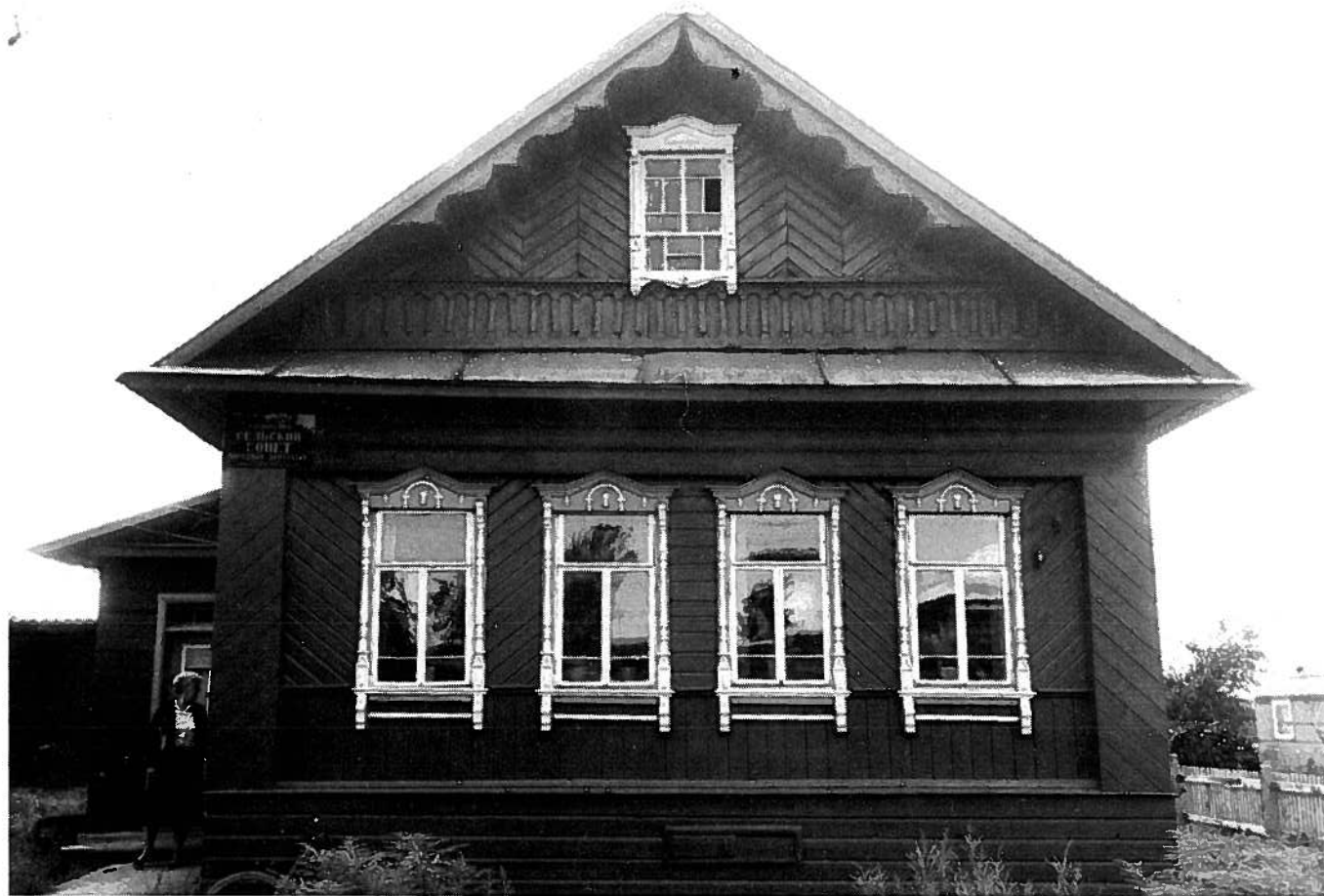
Aljoshovan kylän kunnantalo oli kuin suoraan venäläisestä satukirjasta: vihreäksi maalattu, siisti ja hyvin hoidettu rakennus kyläidyllin keskellä.
