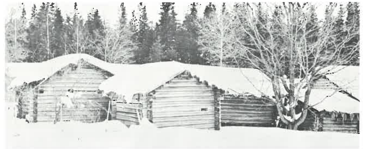
Samat rakennukset takaapäin. Vas. härkäpihatto, talli, lato ja lätti. Valok. kirjoittaja 11. 3. 1956.
