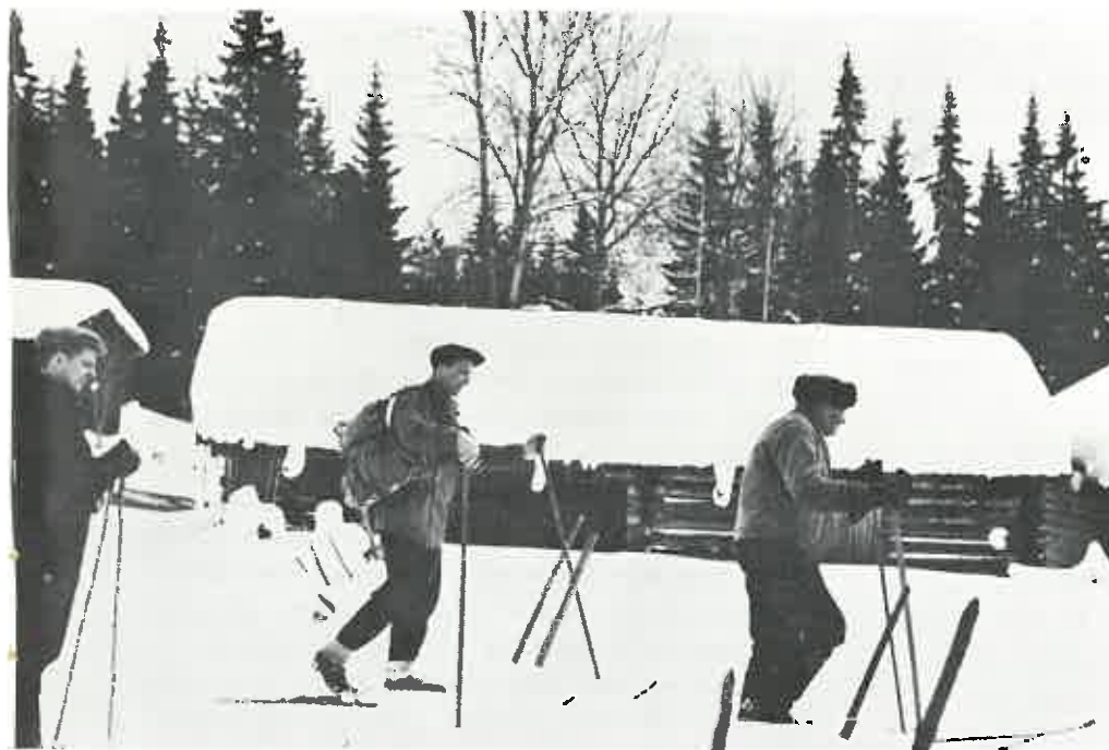
Paksussa suojalumessa tarpon mitattiin ja valokuvattiin asumattoman Haipon rakennuksia 11. 3. 1956. Edellä kulkee naapurin vanhaisäntä Joose Haippo, jota haastateltiin torpan vaiheista. Hänen jäljessään silloinen maisteri Pertti Viitanen ja Joosen poika Urho Haippo. Taustalla navetta, jonka toisessa päässä on ratassuoja. Vasemmalla takana näkyy sauna. Valok. kirjoittaja.
