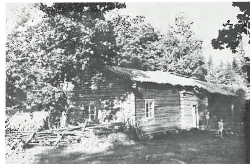
Haipon päärakennus v:ltä 1843, Heikki Matinpojan isännöyden ajalta. Vain länsipäässä oleva pirtti on asuttava. Sen jatkoksi on myöhemmin rakennettu porstua ja permannoton, välikatoton itäpää, jota käytettiin "laskettavana". Valok. kirjoittaja 28.8. 1955.
