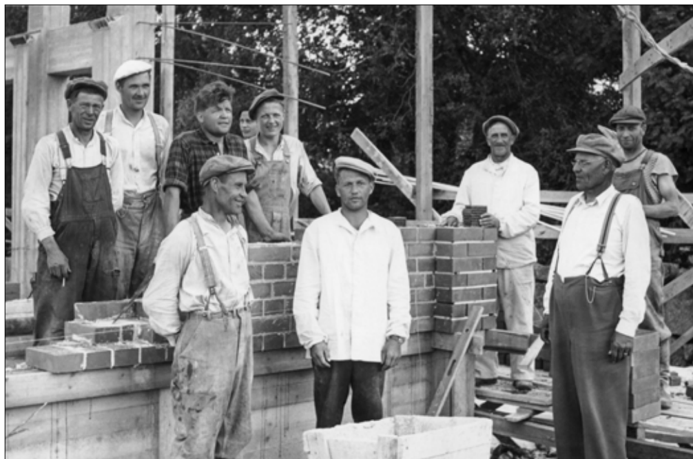
Siunauskappelin työmaalla kesällä 1955. Kuvassa etualalla vasemmalta Lauri Seitsi, Arvo Kallio, Vihtori Kallio, August Kotikoski, Into Härmä. Muurauksen takana toinen vasemmalta Keijo Nurmi, kolmas Kaino Virtanen ja neljäs Erkki Johansson. Muiden nimiä ei ole saatu selvitettyksi.
