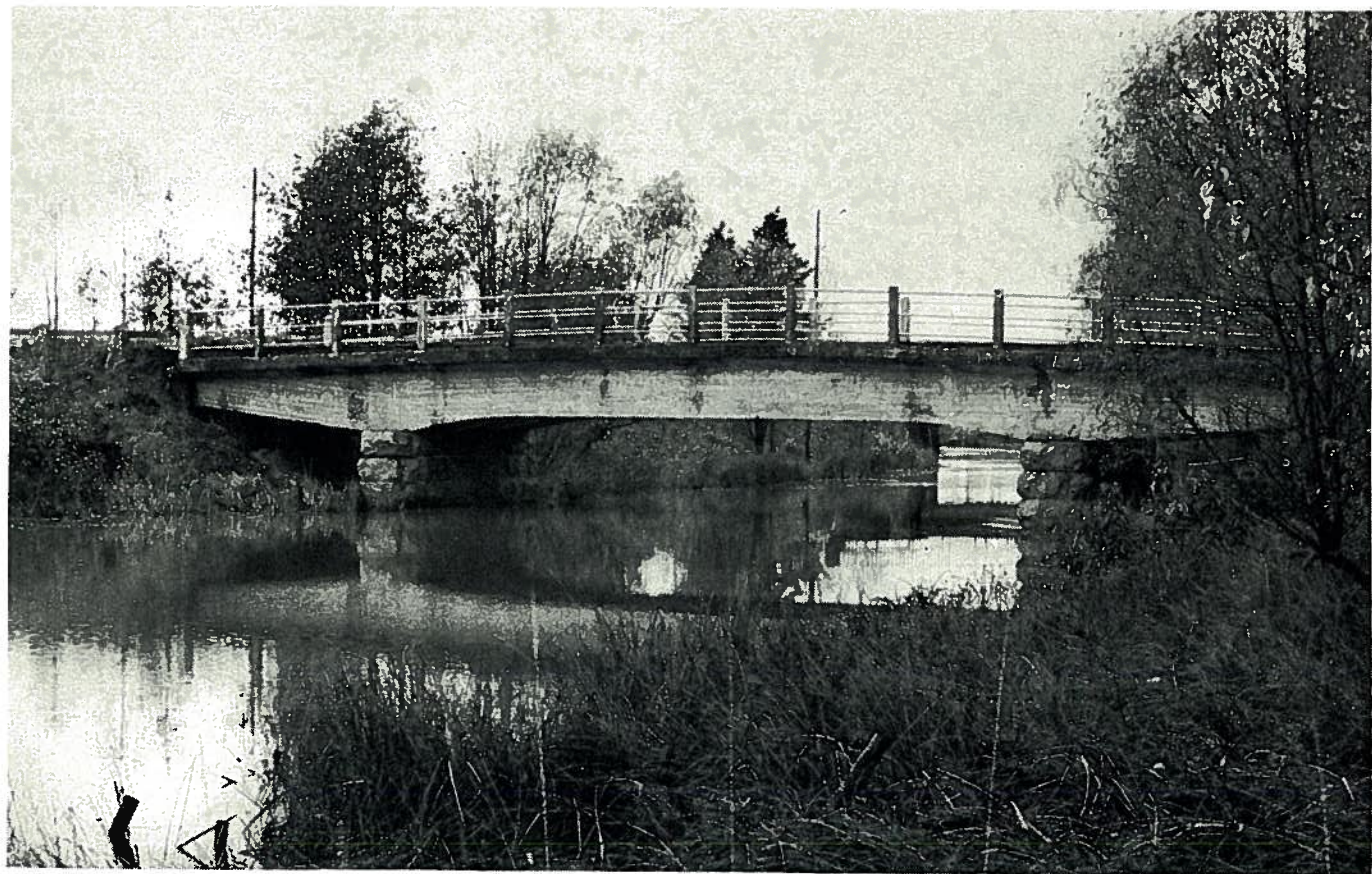
Lammin vanha silta on sirolinjainen. Siltää kannattavat kiviarkut ovat pysyneet hyvin paikoillaan.
