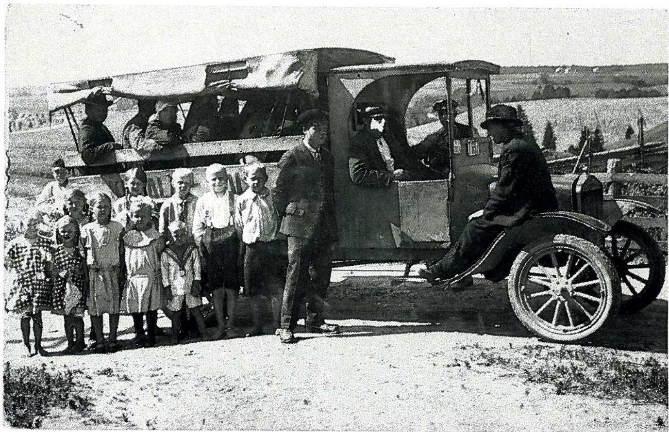
Linja-auto mallia 1924. Autossa oli rautakehikon varassa katto, sivuilla pressut, jotka sateella laskettiin alas. Auto liikennöi linjalla Rekijoki — Salo. Kuvassa olevat lapset ovat menossa pyhäkoulun.
