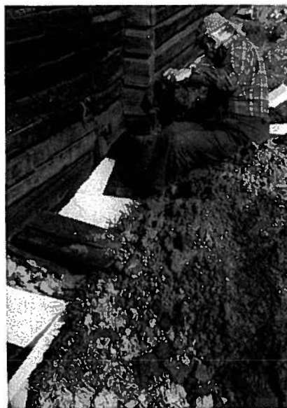
Somero, Jaatila. Lauri Koskinen kaivaa tilaa museon saunan nurkkakiven alle valettavaa betonilaattaa varten. Betonivalu eristettiin tyroksilevyillä. Valok. T. Horila 13. 5. 1981.
