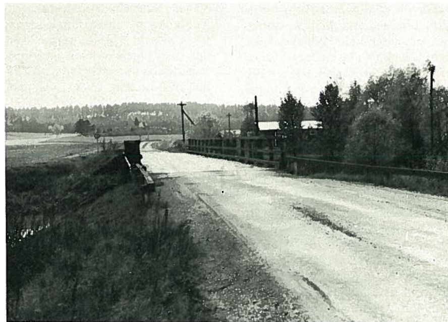
Vilukselan ja Värmälän välinen silta. Kuva: T. Horila.
