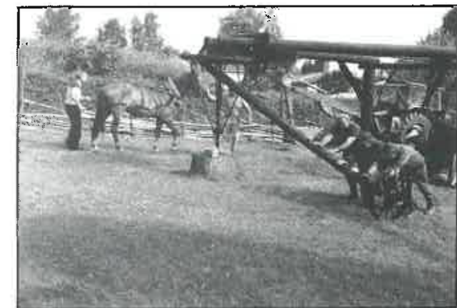
Hevoskierron valmistuminen loppusuoralla. Miehet näyttävät hevoselle, miten hevoskierto saadaan liikkeelle. Valokuva: Voitto Ollonqvist.
