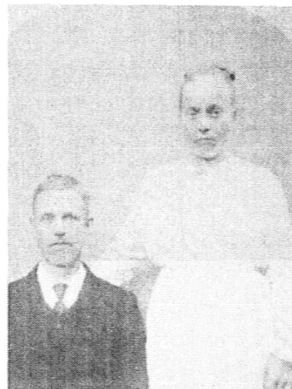
Kuva otettu häähäpäivänä 11.7.1920 Kivennavalla
