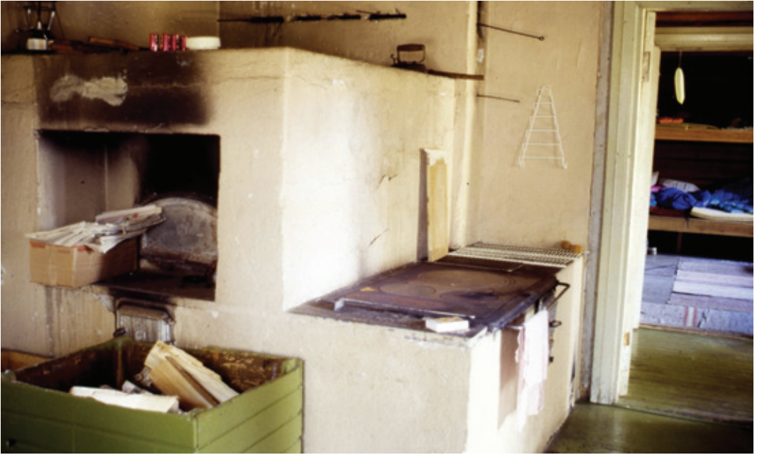
Kämpän vanha uuni purettiin ja tilalle pystytettiin uusi vuolukivi-uuni.
