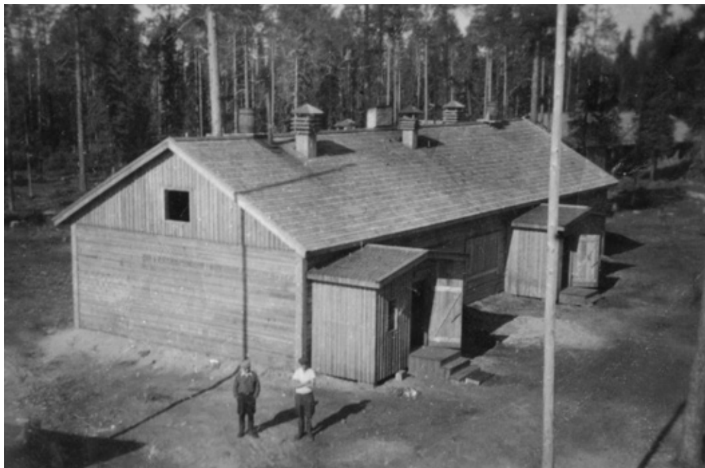
Miehistökämpä esikuntakämpän katolta kuvattuna.
