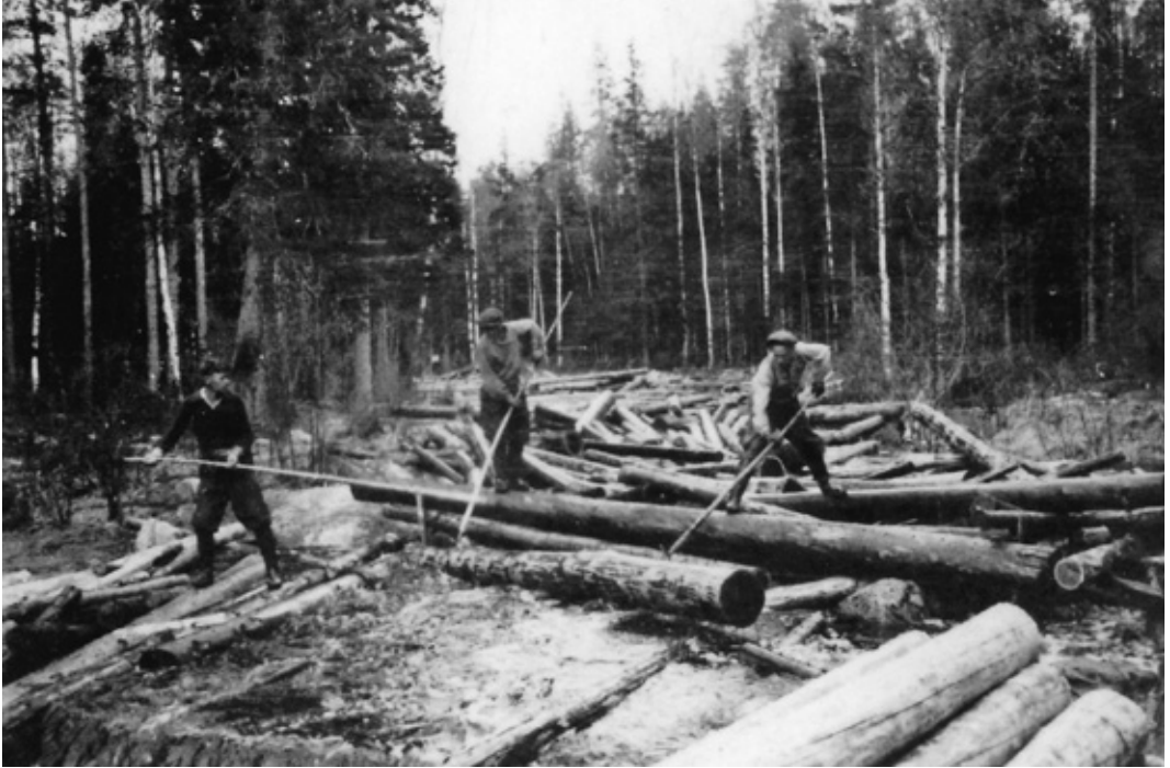
Uiton päättävässä peränajossa joki tyhjennettiin irtopuista ja uittorakenteista.
