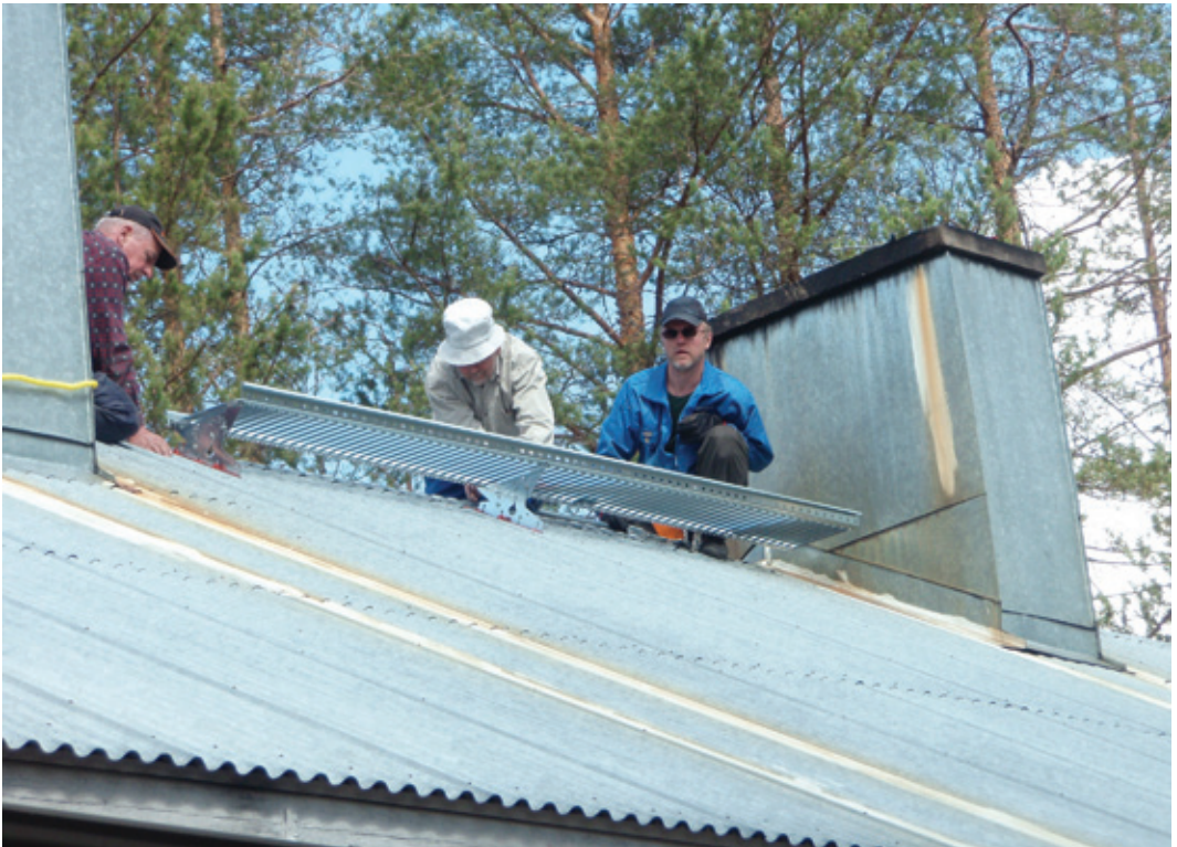
Jaakko Korhonen, Jorma Okkonen ja Ilmo Nousiainen kämpän katolla kulkusiltaa asentamassa.
