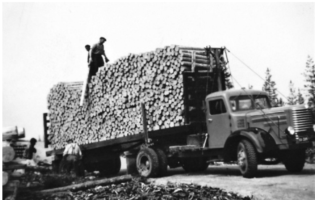
Ukonjoen savotan aikana puita alettiin kuljettaa myös autoilla.
