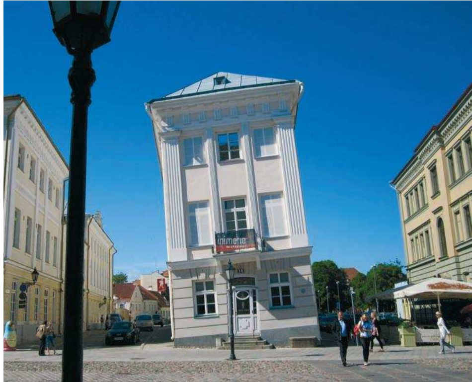
Asiaan kuului tutustua myös paikalliseen rakennustekniikkaan. Kuvan talo on perustettu toiselta reunalta vanhan kaupunginmuurin päälle ja toinen reuna on uudella perustuksella.
