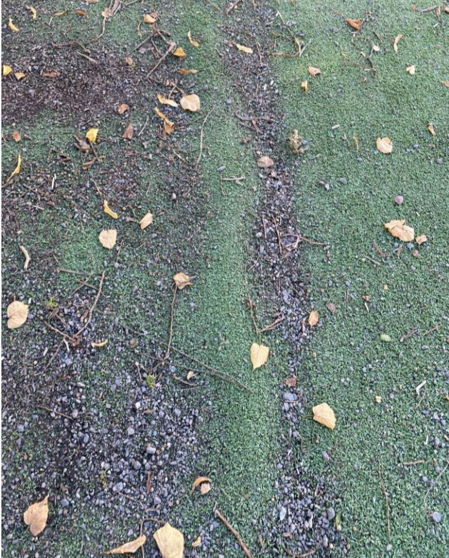
TURVA-ALUSTOJEN KOVETTUMINEN
