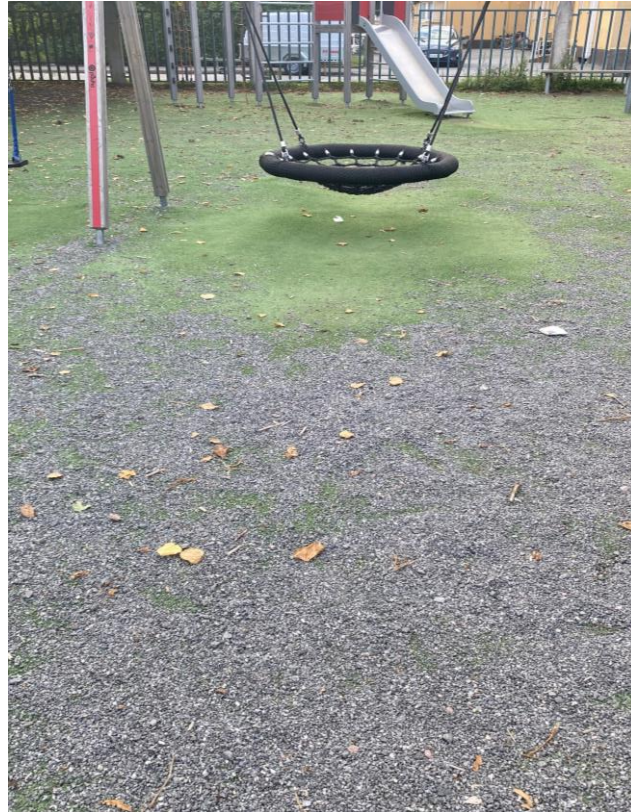
HIEKOITUSSEPELIN KERÄÄNTYMINEN TURVA-ALUSTOILLE
