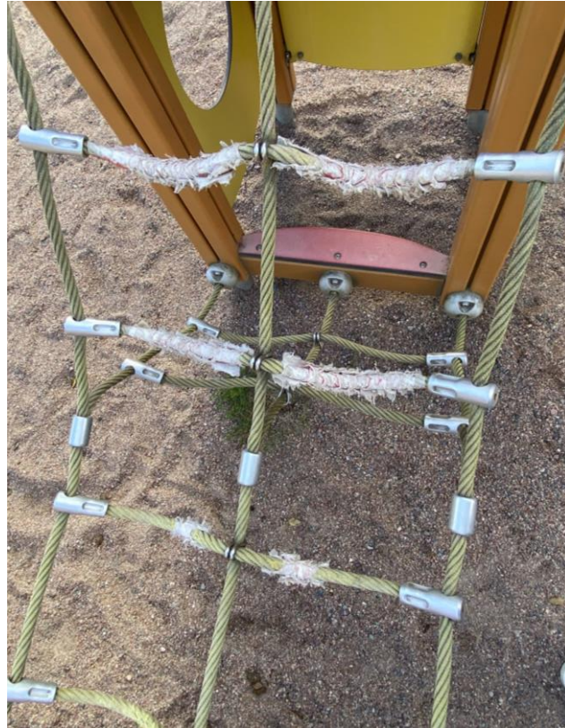
VUOSITTAISET HUOLLOT JA KORJAUKSET PUUTTEELLISET
