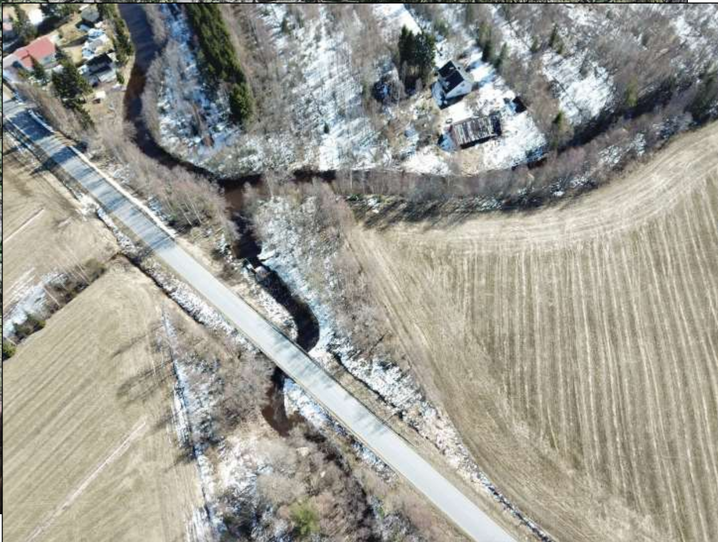
Kuva: Envineer / Väyrynen
