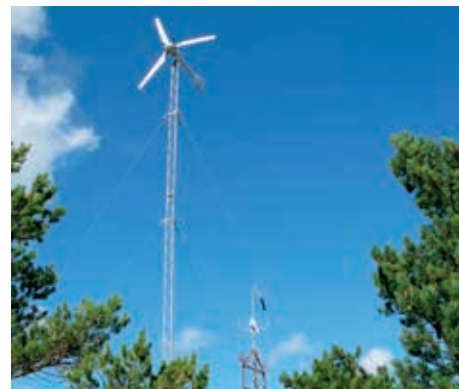
Vindmöllan på midsommarberget, som försörjer Keistiö med el till vägbelysningen.
