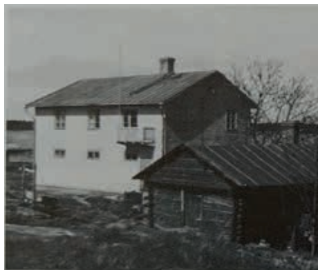
Iniö Lanthandel rakennettiin vuonna 1936. Kuvan on ottanut Åke Strandfelt.
